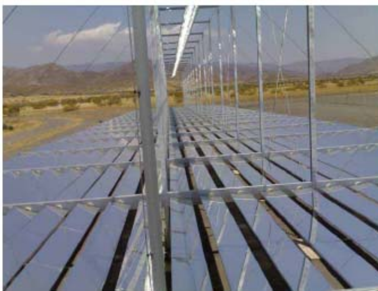
Рисунок 1.1 – ФЭ электростанция мощностью 23 МВт, Алмерия, Испания [3,8,11].
