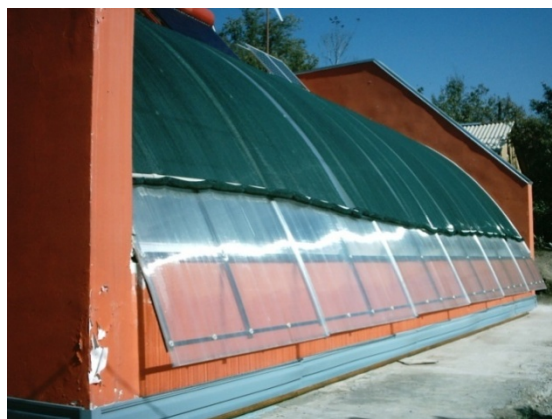
Фото 6 – Изоляция прозрачного ограждения опытной теплицы с внешней стороны
