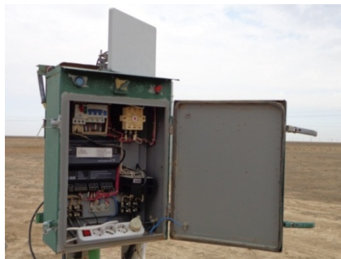
Рисунок 2.5 – Шкаф управления включающий контроллеры Fatek, ОВЕН МЭ110 и модули MOXA беспроводной передачи данных.
