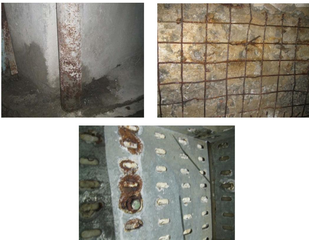
Рисунок – Поврежденные поверхности железобетонных конструкций
